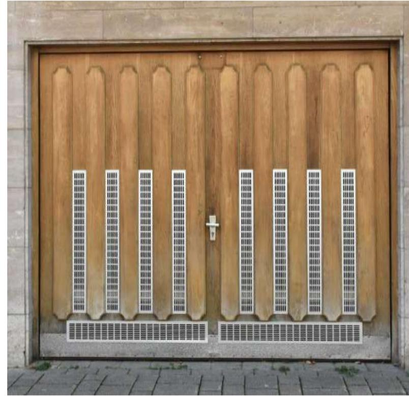
2: „Horch. 3“, Außenbereich, Blick nach Süden auf Garageneinfahrt: zweiflügelige Holztüre mit aufgesetzten Brettern sowie Metall-Lüftungsgittern. Datierung um 1960er.
