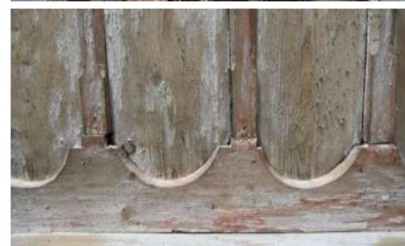
5: Dachboden, Deckenverkleidung der Kehlbalkebene; Randfries in Zierform, Leisten mit abgeschrägtem Auslauf, eingestemmte Füllungen. Datierung um 17. Jh (?).
