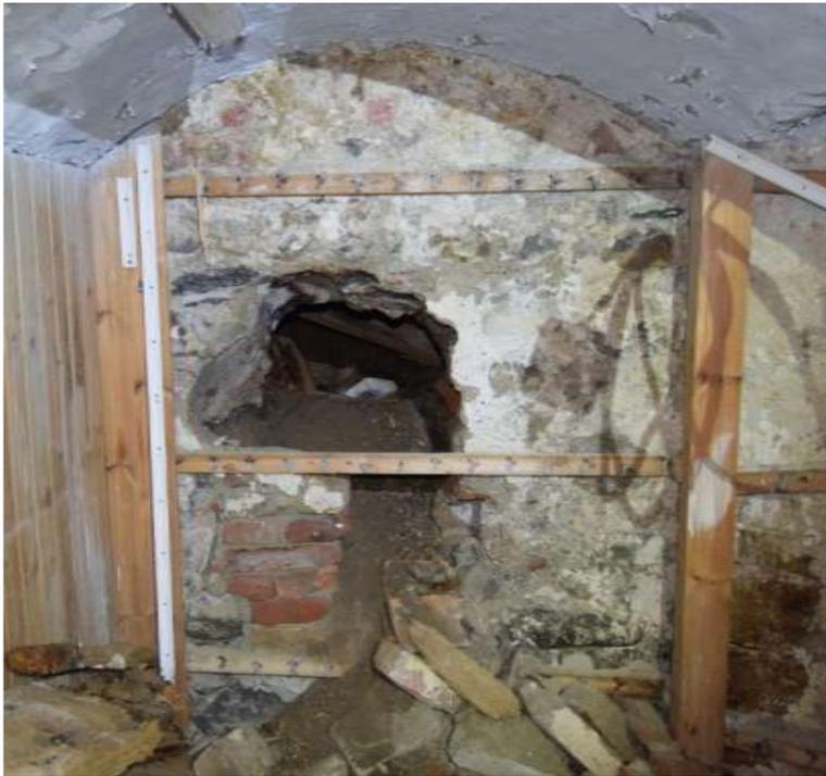
1: Prom. 9, KG, Treppenabgang, Bauteilöffnung im westlichen Mauer: Hinter der Mauer findet sich eine Art Hohlraum.
